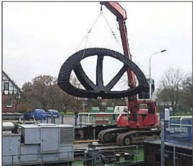
Schweres Gerät ist erforderlich, um die Kammradhälften hochzuheben.
