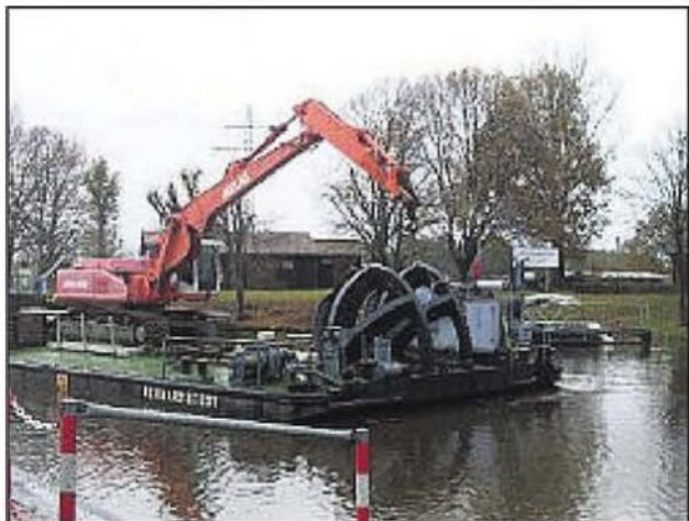
Mit einer Schute werden die beiden Kammradhälften auf die Insel transportiert, wo sie auf ihren Einsatz als Wegweiser zur Oldauer Schleuse warten.
