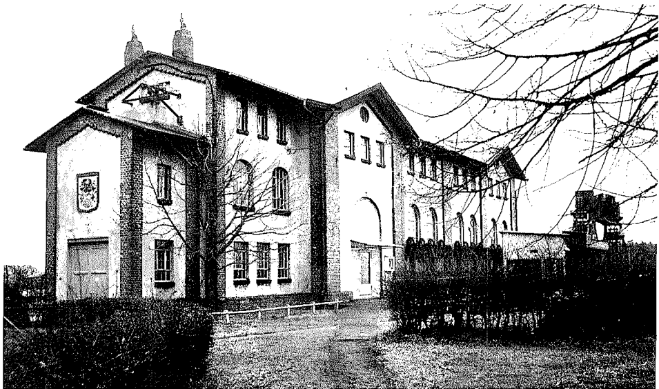
Abb. 5. Wasserkraftwerk in 3101 Hambühren-Oldau 1973
