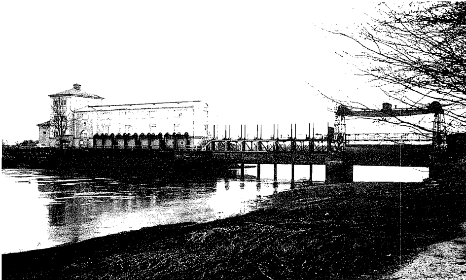
Abb. 1. Wasserkraftwerk mit Wehr in 3031 Buchholz (Aller)–Marklendorf, 1973, Kraftwerk 1974 abgebrochen
