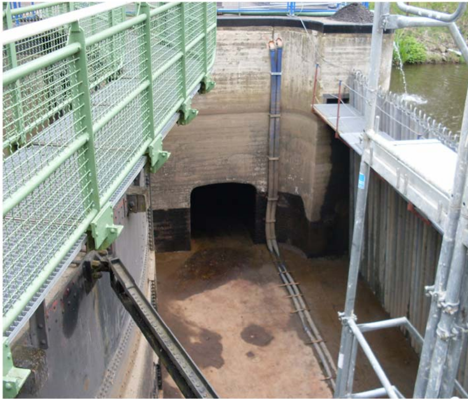
Das trockengelegte Schleusentor der Schleppzugschleuse in Hademstorf.
