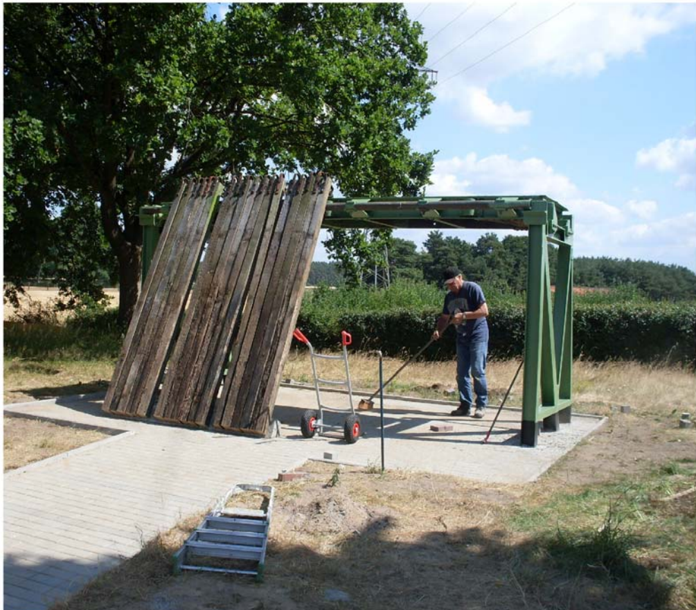
.....unten liegen die Nadeln auf der Schwelle auf
