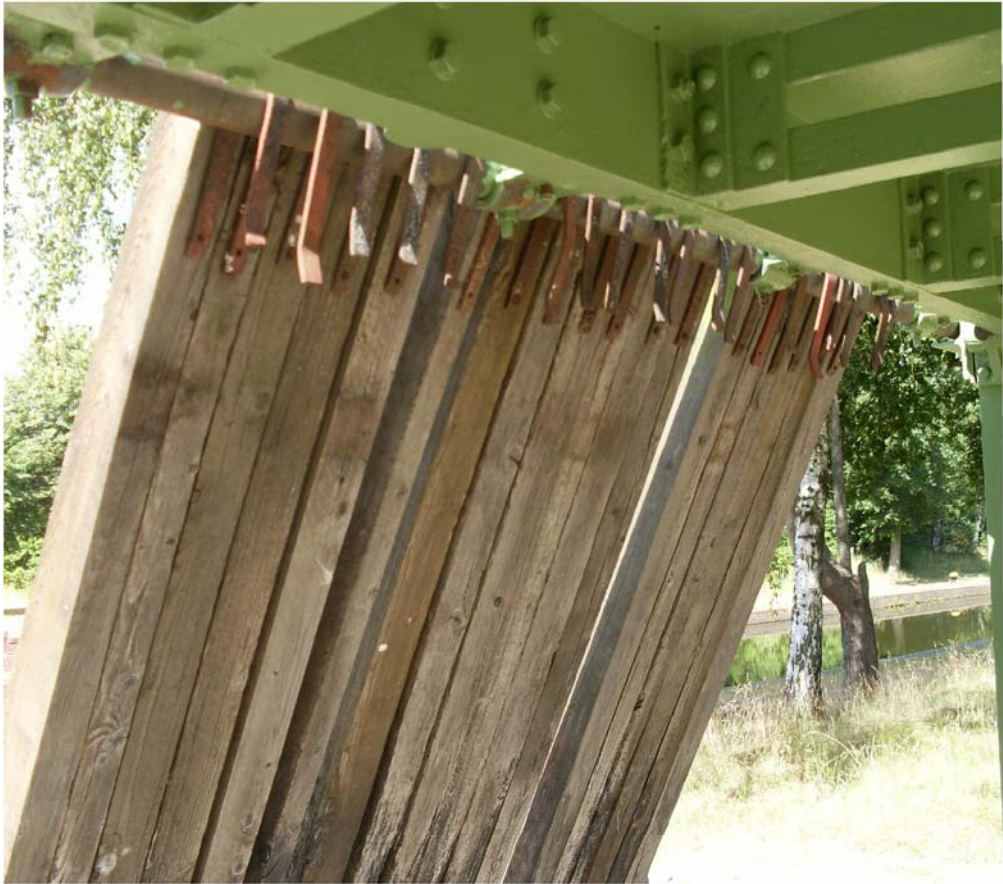
Die Nadeln sind gekürzt und hängen oben mit den Stahlklammern auf der Nadellehne,.....
