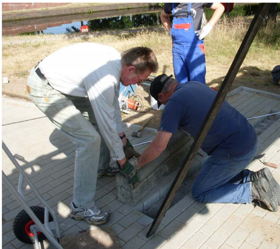
Der erste Stein wird in den Beton gesetzt
