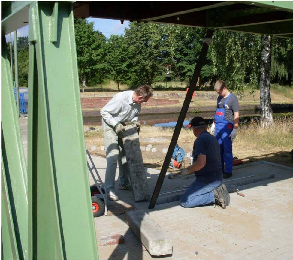
Das Material für die Schwelle wird zur Baustelle gebracht
