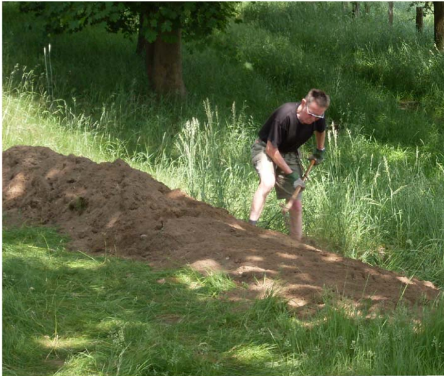
Mit dem ausgehobenen Erdreich wird der Deich an der Schleuse verstärkt.
