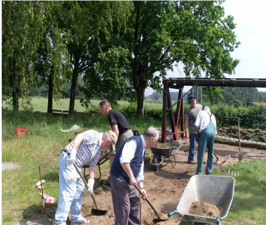
Die Arbeitsgruppe 70+ bereitet die Pflasterung für das Nadelwehr vor.
