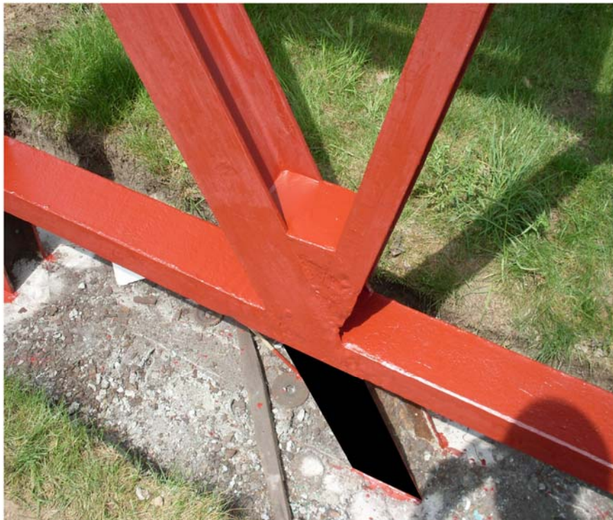
Unterhalb der Querträger werden die Träger mit Bitumenfarbe gestrichen.
