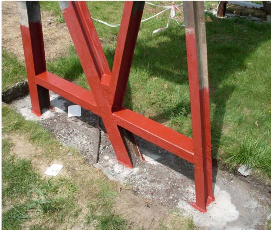
Der erste Anstrich mit Rostschutzfarbe ist aufgetragen.
