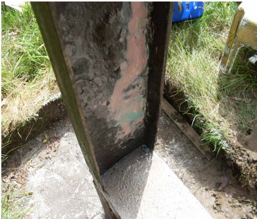
Mit Glasfaserspachtel werden die weggerosteten Stellen aufgefüllt.
