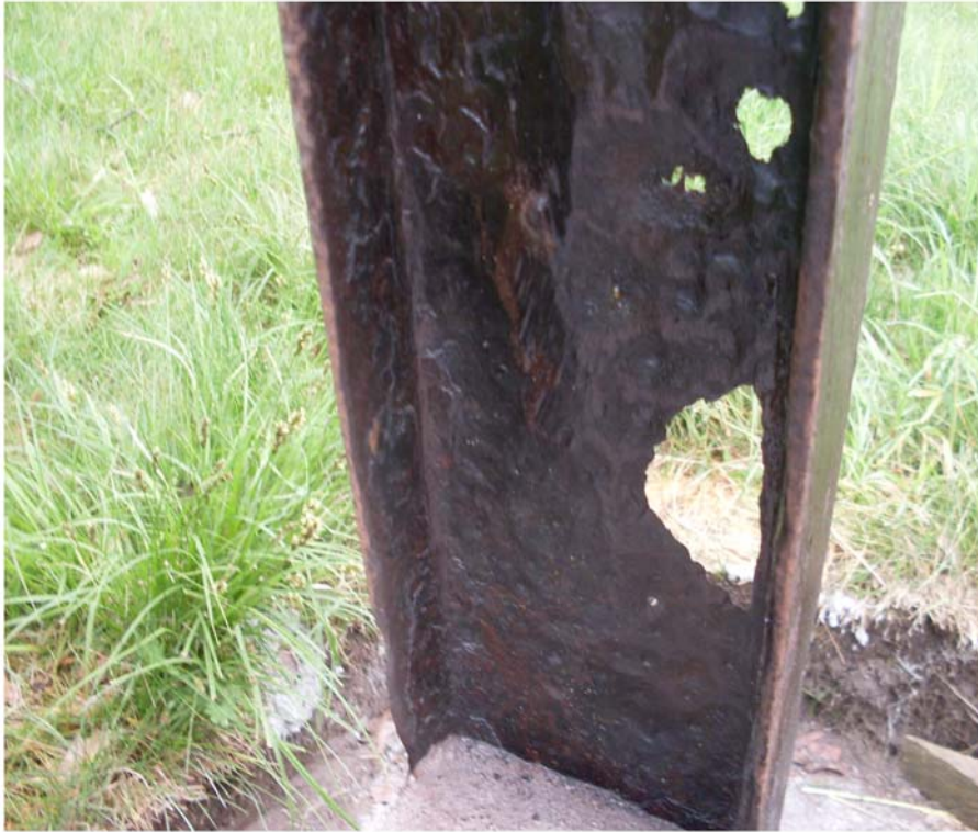
Die durchgerosteten Stellen wurden mit Rostumwandler behandelt.
